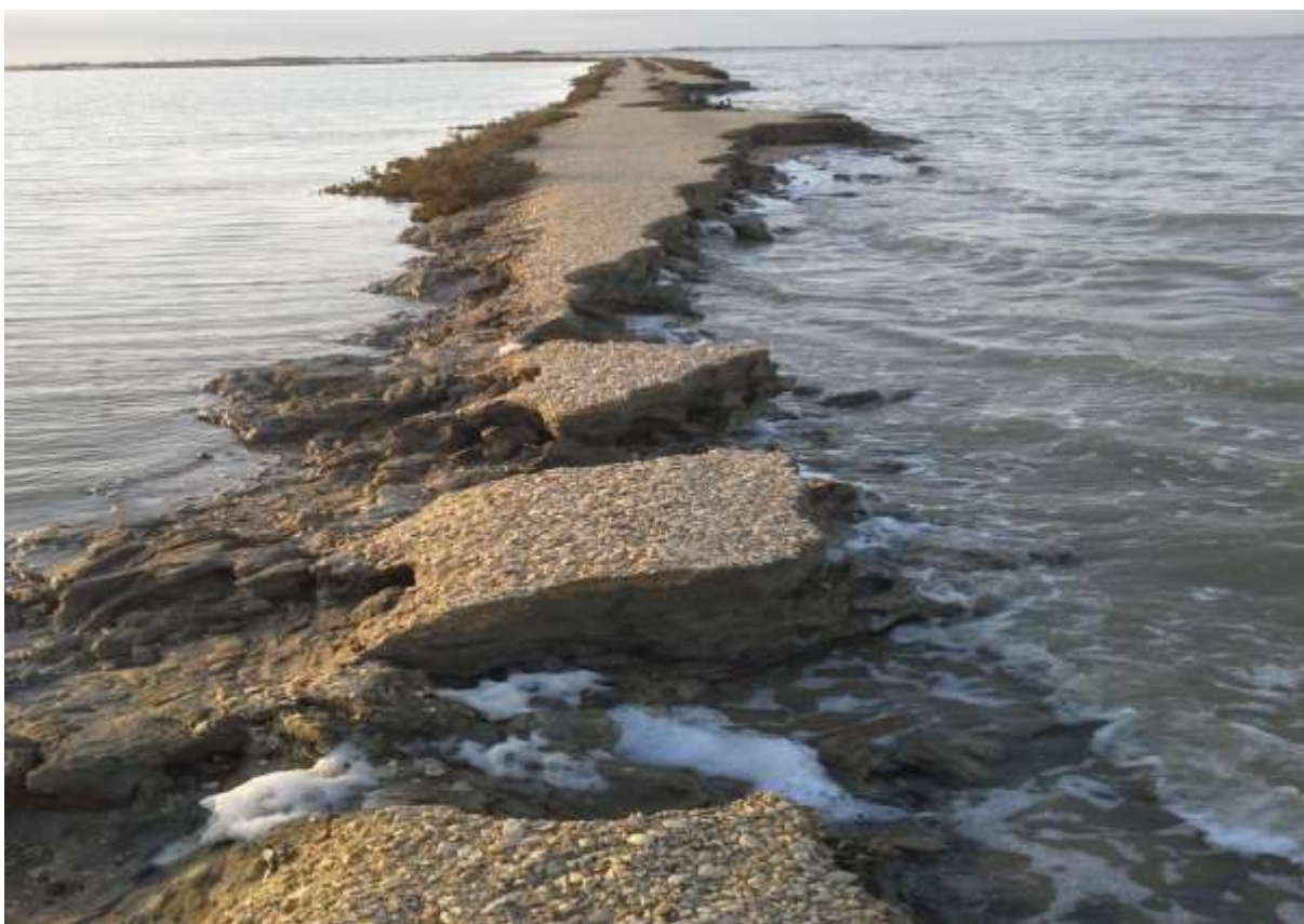
Digue quasi bréchée entre le grand Rascaillan et le clos de Quarantaine 3 (novembre 2014)
