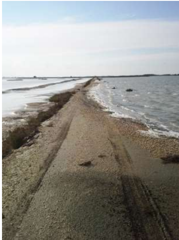
A droite Quarantine 3, rempli par le coup de mer, surverse dans le Vaisseau (à gauche) et altère la digue de séparation appartenant au groupe Salins (novembre 2014)
