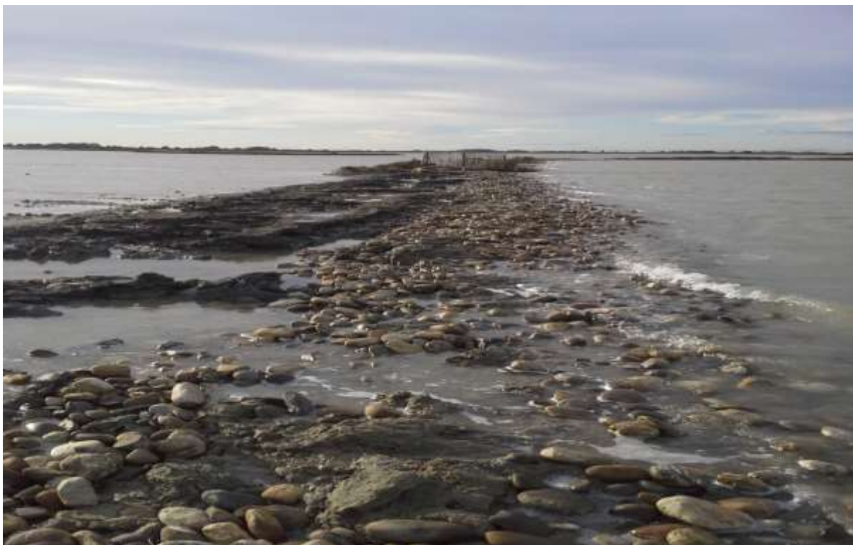
Digue lessivée et quasi détruite entre le grand Rascaillan et le pourtour 2 (novembre 2014)
