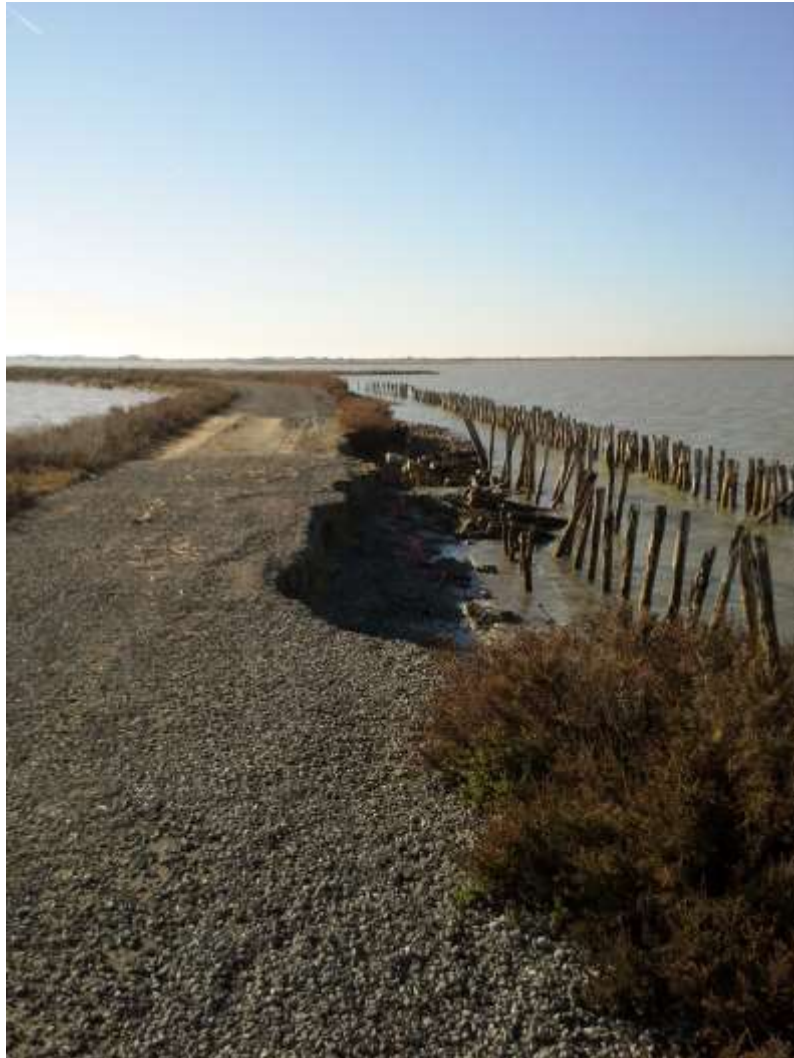
Atteintes sur la digue à la mer entre le Fangassier et le Galabert sur les versants exposés aux basculements de plans d'eau par mistral fort (début janvier 2015)
