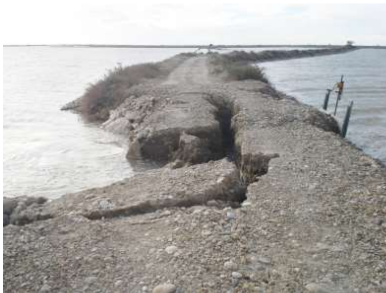
Le coup de mistral du 24 janvier 2015 a définitivement détruit l'ouvrage situé entre le Galabert et le Tampan
