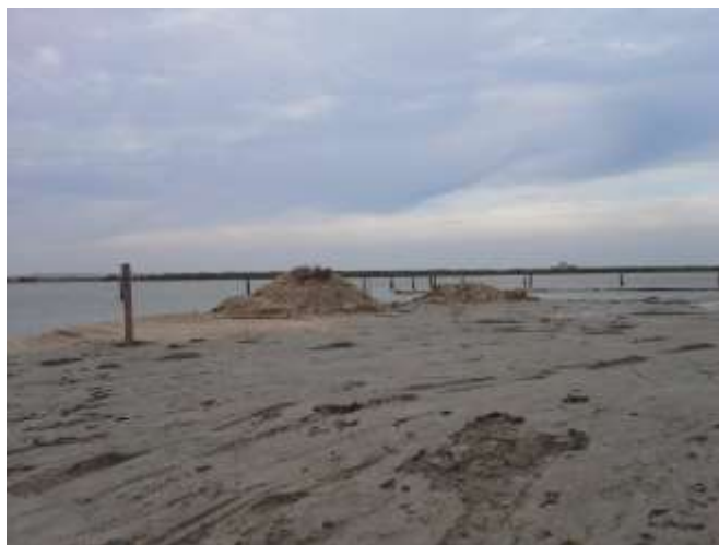
Profilage de l'ilot terminé, reste à épandre le sable coquiller...
