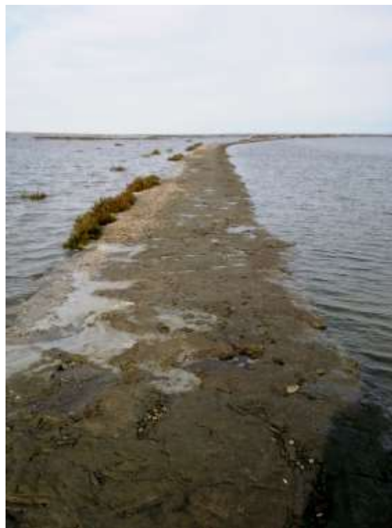
Les matériaux de recouvrement de la digue séparant le Rascaillan du clos 3 de Quarantaine ont été emportés par le coup de mer (Novembre 2014)
