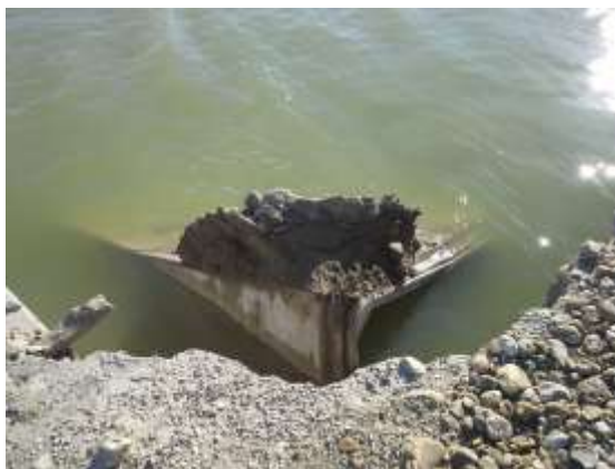
Elément en béton de l'ancien ouvrage effondré suite aux coups de mer de l'automne 2014
