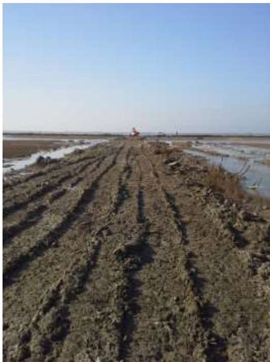
Renforcement de la berge nord de l'ancien Salin de la Vignole pour assurer la maîtrise des niveaux d'eau
